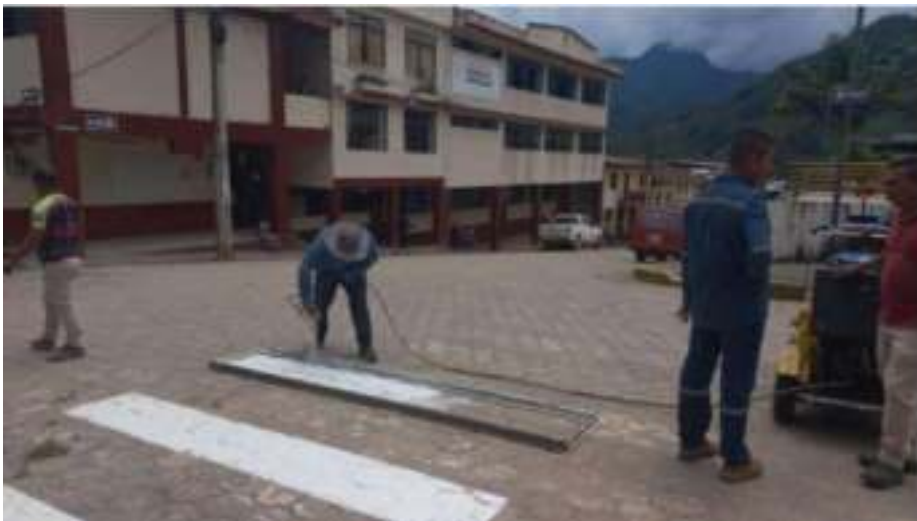
Ilustración 9 Trabajos realizados en Yacuambi 10-11-2021 / 19-11-2021 (libro de obra)
