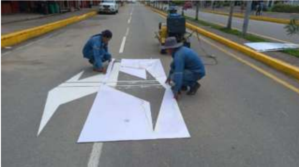
Ilustración 7 Trabajos realizados en el cantón Paquisha 15-10-202/ 27-10-2021(libro de obra)
