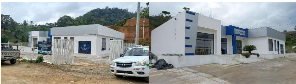
Ilustración 16. Avance físico del nuevo edificio central de la EMMSZACH E.P.
