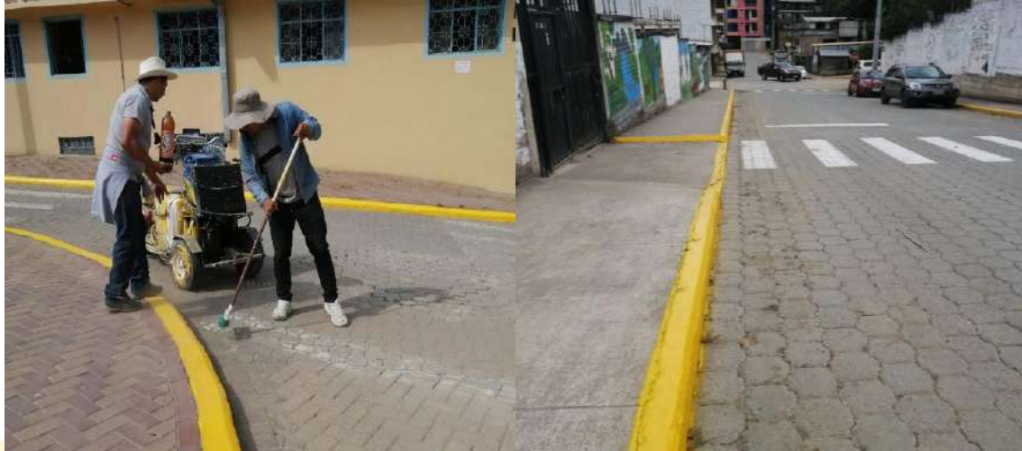
Ilustración 7. Señalización horizontal en el cantón Palanda
